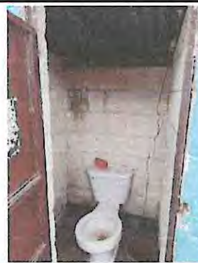
Foto 2: Sustitución de lámina acanalada por lámina troquelada calibre 26, sustitución de estructura de madera por estructura metálica galvanizada en baños.
