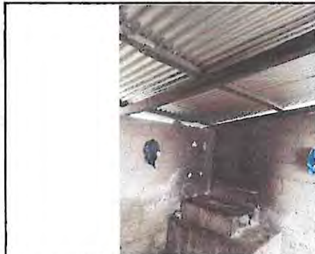
Foto 3: Sustitución de lámina acanalada por lámina troquelada calibre 26, sustitución de estructura de madera por estructura metálica galvanizada en corredor y cocina
