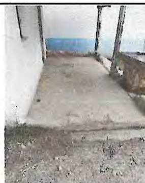
Foto 6: Sustitución de pila por pila
