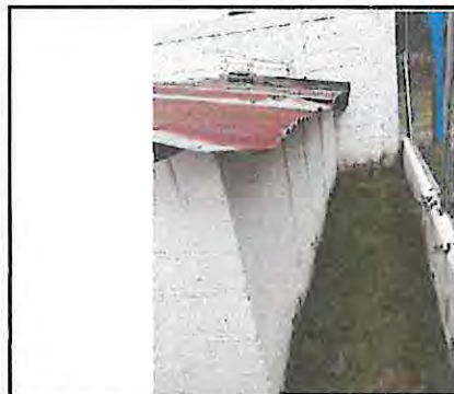
Foto 5: Sustitución de lámina acanalada por lámina troquelada calibre 26, corredor y cocina, vista de atrás de la cocina
